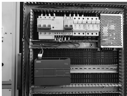
图 1-1-9 PLC 控制线路布置图
